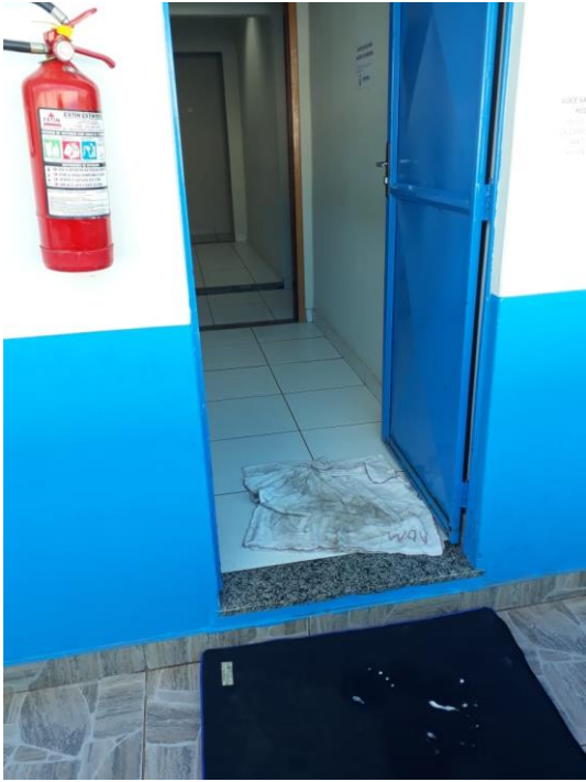
Pedilúvio nas entradas do administrativo.
